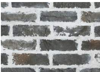
Over Grouting การลงยาแนวแบบปาดหน้า
